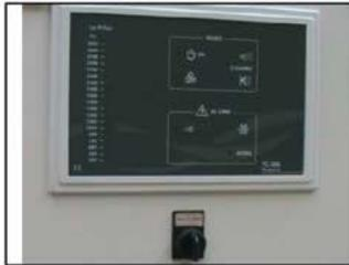
Flexibilität: Elektronische Filtersteuerung. Kosteneinsparung durch reduzierten Energieverbrauch. Werte: PUIS- und Pausenzeit, Zyklen, Nachlauf, Sollwert Differenzdruck. Schaltschrank komplett und anschlussfertig verdrahtet nach behördlichen Vorschriften.
